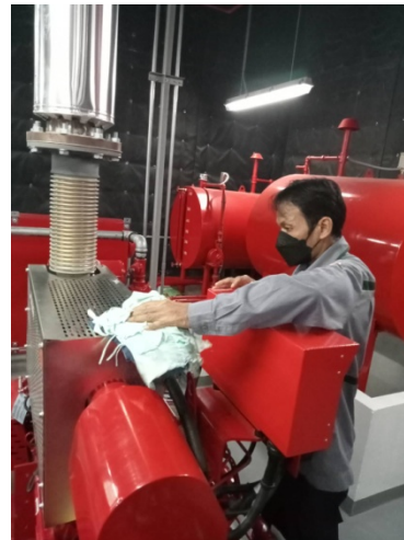
ภาพที่ 3-36 ตรวจสอบและซ่อมบำรุงระบบ Fire Pump
