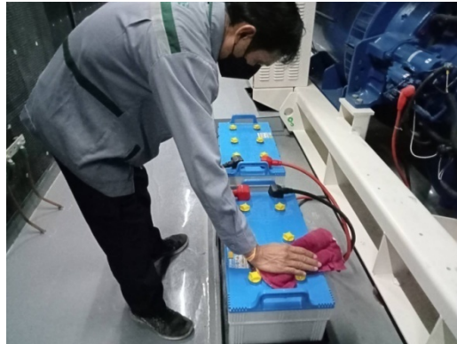
ภาพที่ 3-35 ตรวจสอบและซ่อมบำรุง Generator
