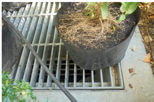
ภาพที่ 3-19 บ่อตรวจคุณภาพน้ำฝาดะแวงเหล็ก และภายในมีตะแกรงดักขยะ
