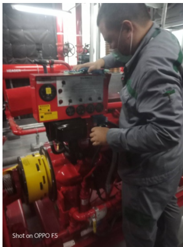
ภาพที่ 3-36 ตรวจสอบและซ่อมบำรุงระบบ Fire Pump
