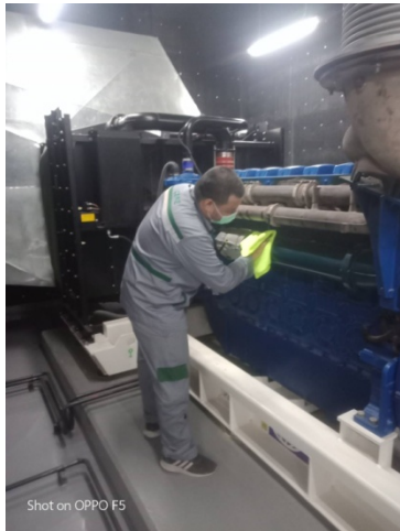
ภาพที่ 3-35 ตรวจสอบและซ่อมบำรุง Generator
